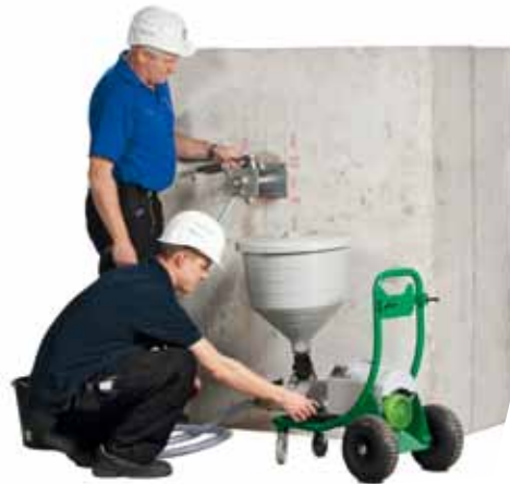
Verpressen des Ankers über die Zuführung im Montagebehelf mit spezieller Mörtelpumpe
