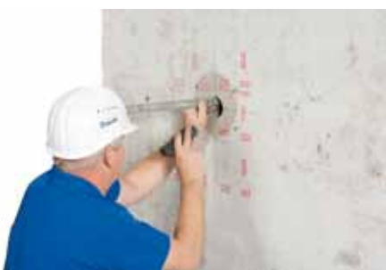
Kontrolle des fertigen Hinterschnitts mit spezieller Lehre
