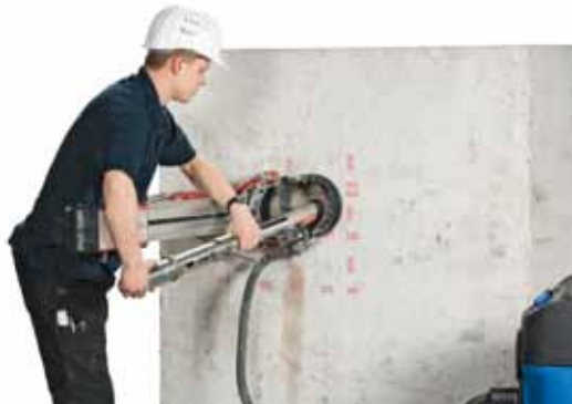
Einführen des Hinterschneidekopfs in die Kernbohrung
