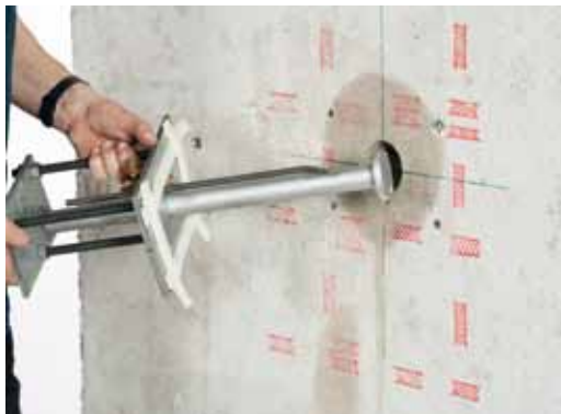
Einsetzen des auf dem Montagebehelf lagegenau fixierten Ankers ins Bohrloch
